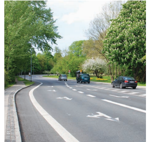
B - Peder Falsters Vej som skiller gymnasium fra bymidte
