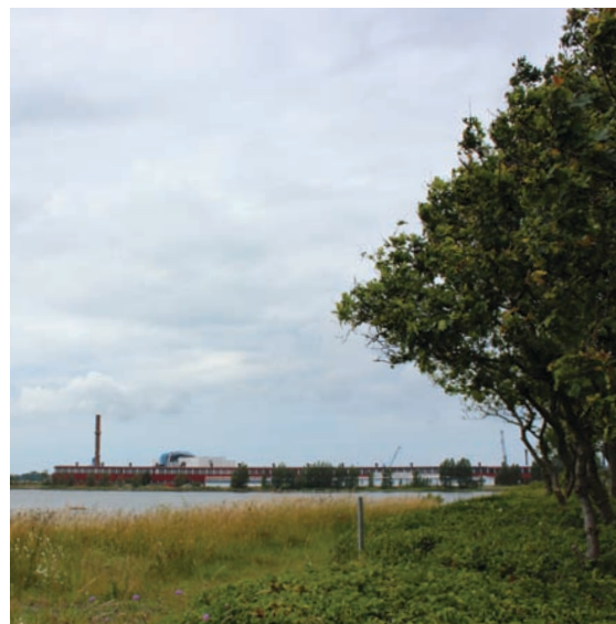
C - Stålvalseværket set fra Strandvejen til Kregme
